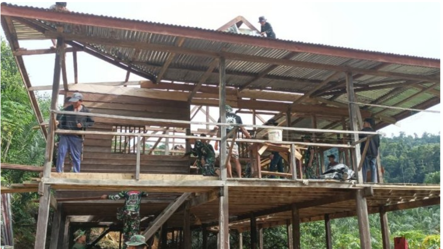
Foto Pembongkaran Rumah Warga
